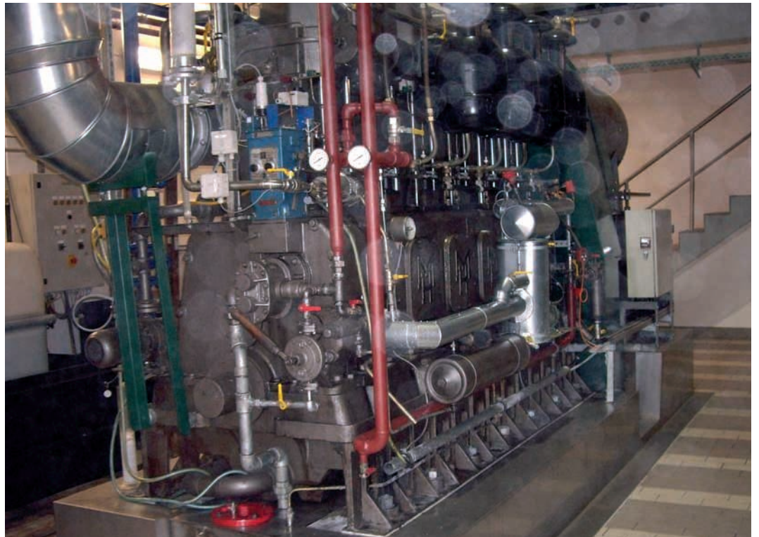
Abbildung 2: Blockheizkraftwerk (BHKW). Ein Dieselmotor vom Typ 6 H 280 der Motorenfabrik Herford mit niedriger Drehzahl wurde speziell an den Betrieb mit gebrauchtem Friteusenfett aus den deutschen McDonald's Restaurants angepasst. Der von einem Generator erzeugte Strom wird in das Stromnetz eingespeist. Die Abwärme kann für industrielle Zwecke genutzt werden.
