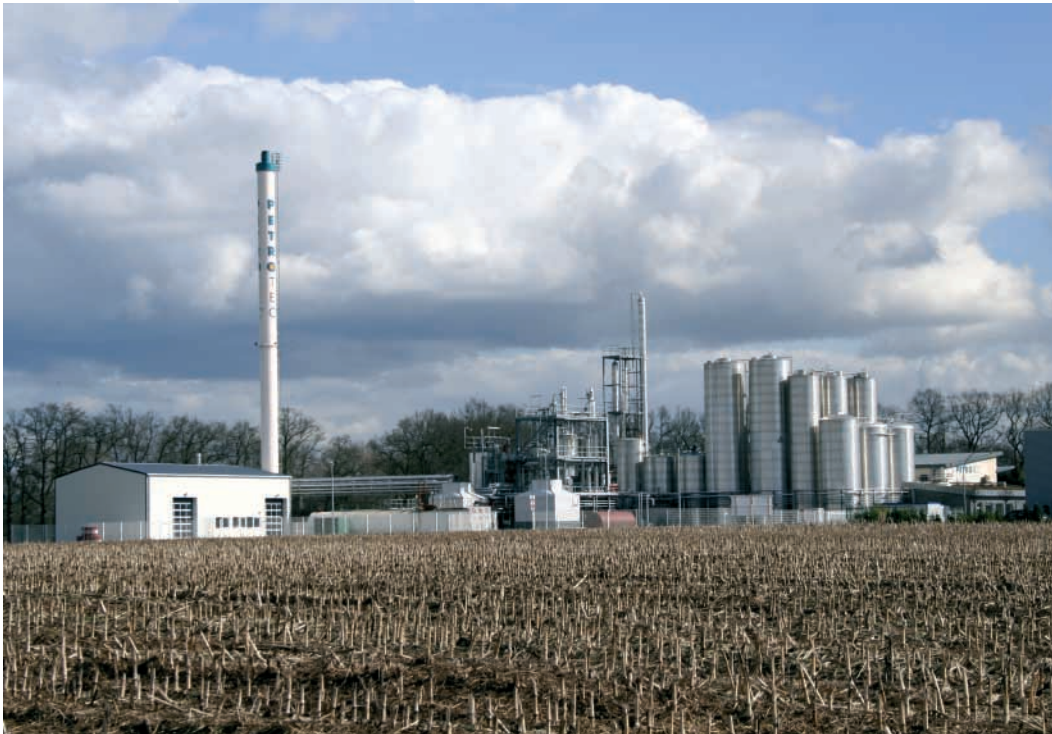
Abbildung 7: Produktionsanlage für Biodiesel. Modernste Anlagentechnik macht aus einem gebrauchten Friteusenfett einen biogenen Kraftstoff: Methylester bzw. „Biodiesel“. Quelle: PETROTEC GmbH, Borken-Burlo
